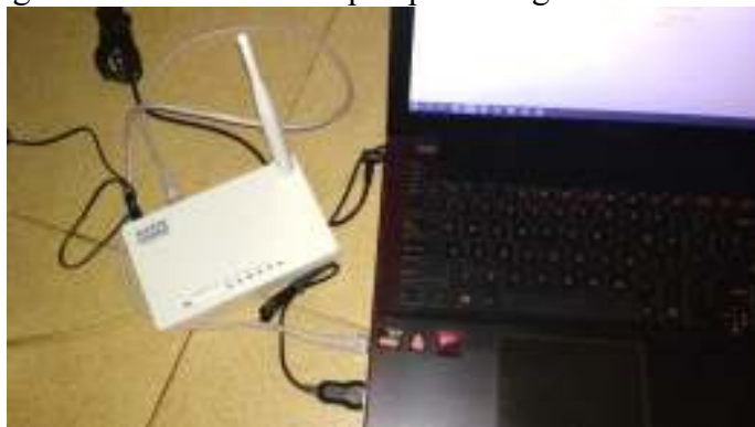
Gambar 5. Pemasangan Kabel UTP
