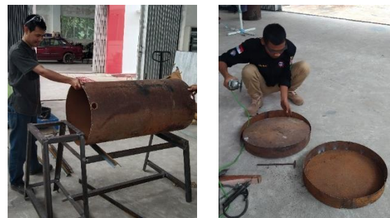
(a) (b) Gambar 2. (a) Penyetelan silinder ruang pengering pada rangka (b) Pembuatan tutup silinder ruang pengering
