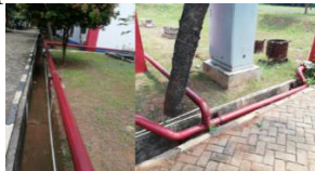
Gambar 5. Instalasi perpipaan hidran
