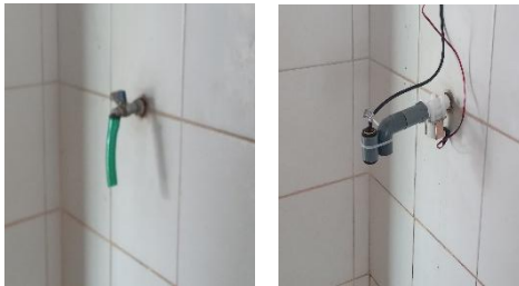
Gambar. 10 Penggantian Kran Air
