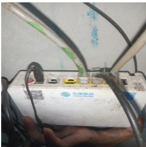
Gambar 5 Pemasangan Kabel LAN ke HUB
