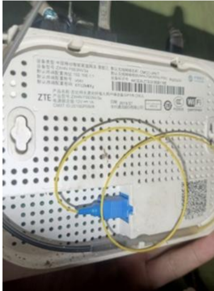
Gambar 4 Pemasangan kabel fiber optik ke modem
