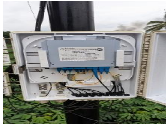
Gambar 2 Pemasangan kabel fiber drop core ke ODP
