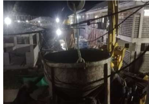
Gambar 9. Pengecoran Ramp
