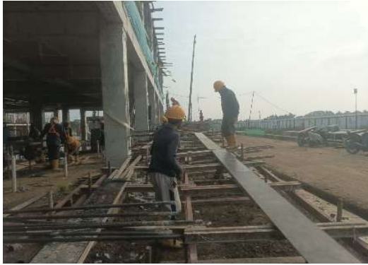
Gambar 4. Pemasangan Bekisting dan Perancah Ramp
