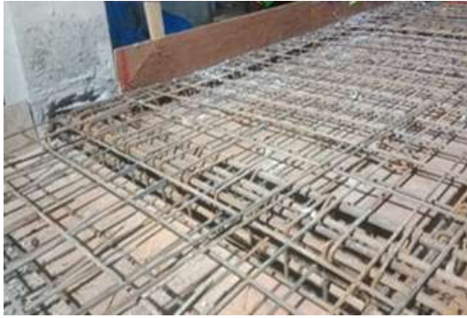
Gambar 7. Tampak Tulangan Ramp
