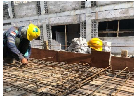
Gambar 6. Pemasangan Tulangan Ramp.
