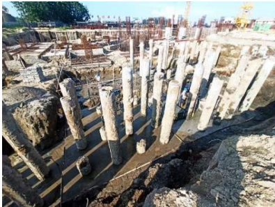
Gambar 1. Pembobokan Kepala tiang pancang (Hasil Dokumentasi Lapangan,2026)
