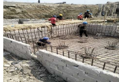
Gambar 3. Penulangan PileCap (Hasil Dokumentasi Lapangan,2026)
