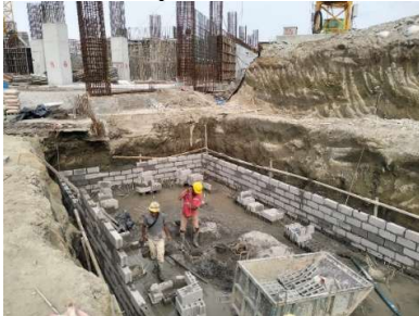
Gambar 2. Pengurugan dan Pemasangan Lantai Kerja (Hasil Dokumentasi Lapangan,2026)
