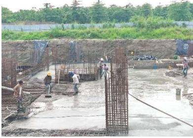
Gambar 4. Pengecoran PileCap (Hasil Dokumentasi Lapangan,2026)
