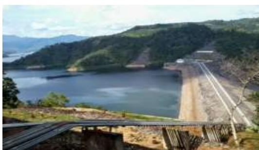
Gambar 1. Bendungan Batutegi Lampung
