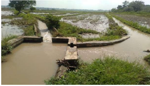
Gambar 4. Box Tersier Tanpa Pintu Saluran KR 2A Kiri Desa Purwodadi Kecamatan Trimurjo Kabupaten Lampung Tengah (Sumber: Riedo Riswan Pratama, 2023)
