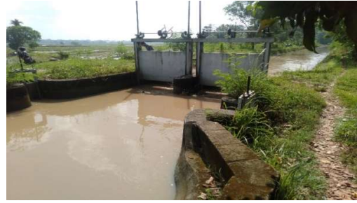
Gambar 2. Bangunan Bagi-Sadap Saluran KR 2A Kiri Desa Purwodadi Kecamatan Trimurjo Kabupaten Lampung Tengah (Sumber: Riedo Riswan Pratama, 2023)
